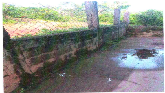
Foto 6: Reparación de muro perimetral
