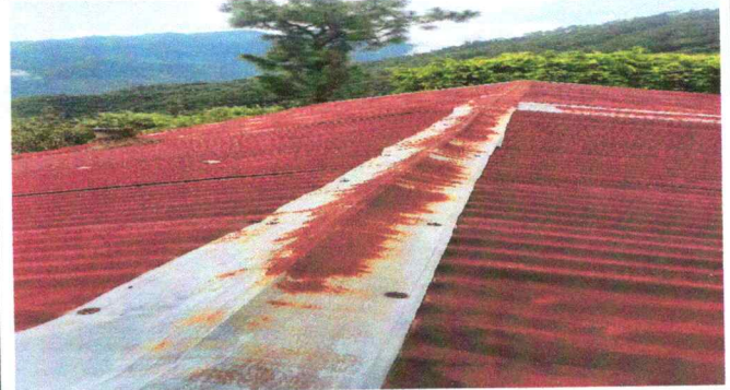
Foto 2: Sustrucción de lámina, por lámina troquelada aluzinc calibre 26
