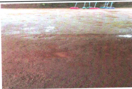
Foto 5: reparación de piso de torta de concreto
