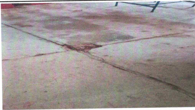
Foto1: Sustrucción de piso
