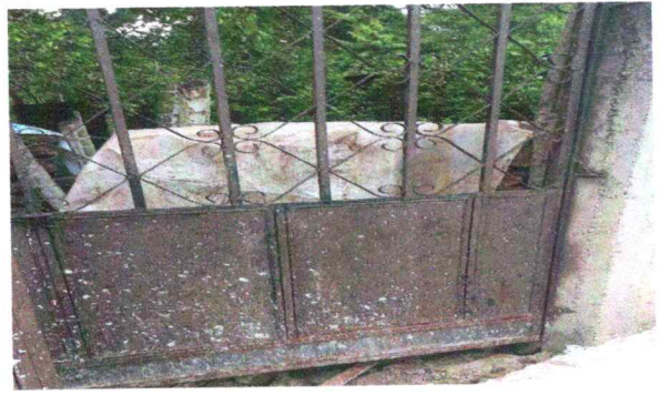
Foto 4: Cambio De Porton
