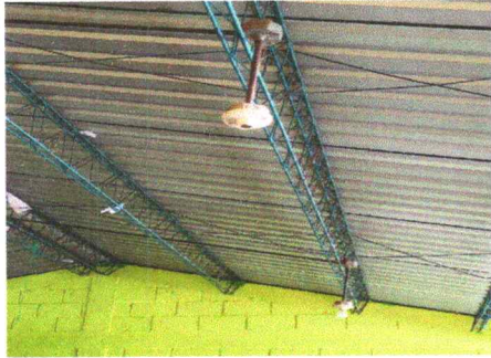
Foto7: Sustitución de lamparas tipo LED
