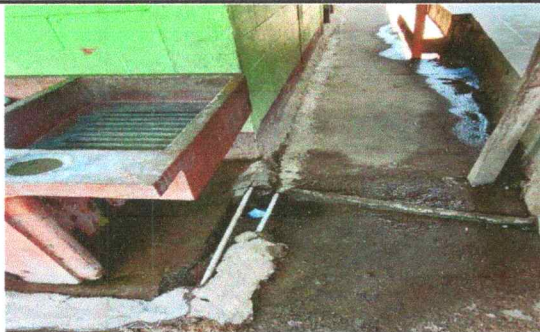
Foto 5: Reparación de red de drenaje
