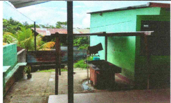
Foto 2: Estructura de techo para pila
