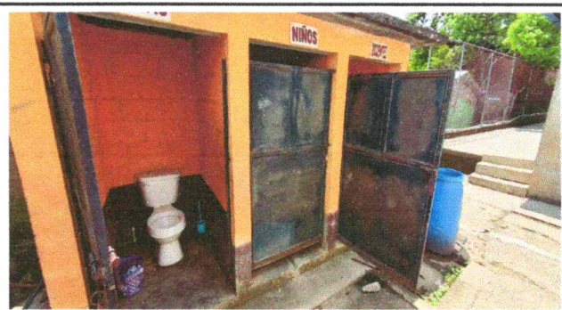
Foto 4: Sustitución de inodoros
