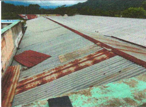
Foto1: Sustitución de lámina troquelada calibre 26
