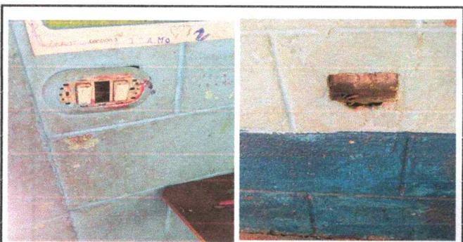
FOTOGRAFIA No. 5 SUSTITUCION SISTEMA ELECTRICO
