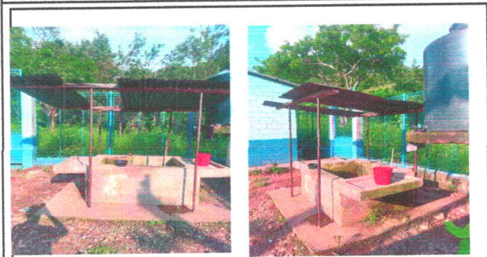
Foto 1: SUSTITUCION CUBIERTA DE LAMINA
