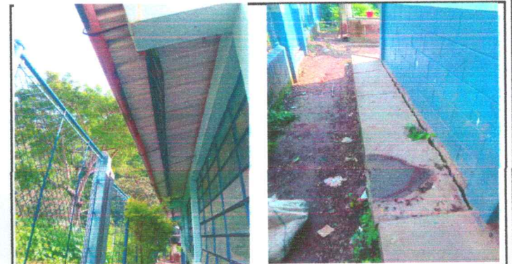
Foto 4: SUSTITUCION DE CANALES. SUSTITUCION BANQUETA.
