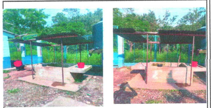
Foto 2: SUSTITUCION DE SOPORTE ESTRUCTURA DE TECHO
