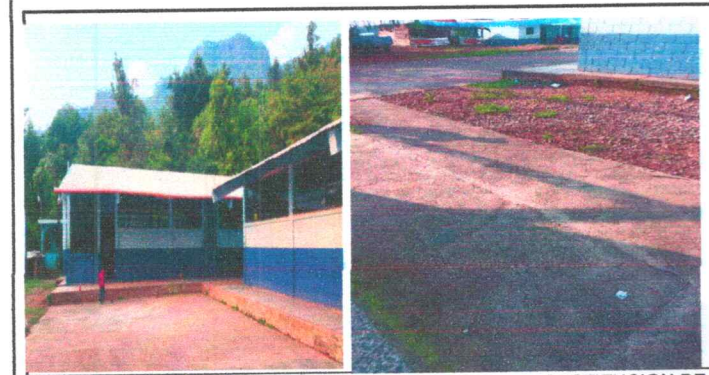
Foto 5: SUSTITUCION DE PINTURA Y CIRCULACION. SUSTITUCION DE PLANCHA DE CONCRETO DE PATIO
