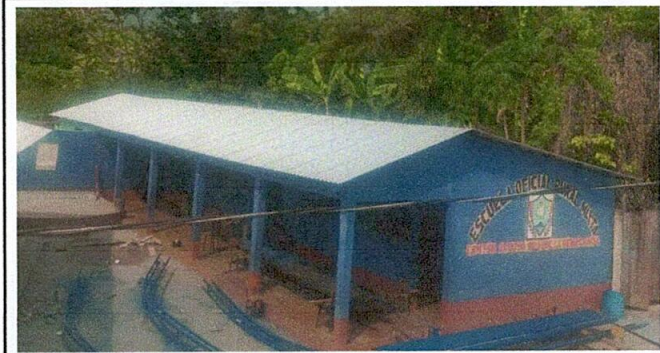
Foto1: EL NUEVO TECHO DEL MODULO 1 DE LA ESCUELA YA INSTALADO.
