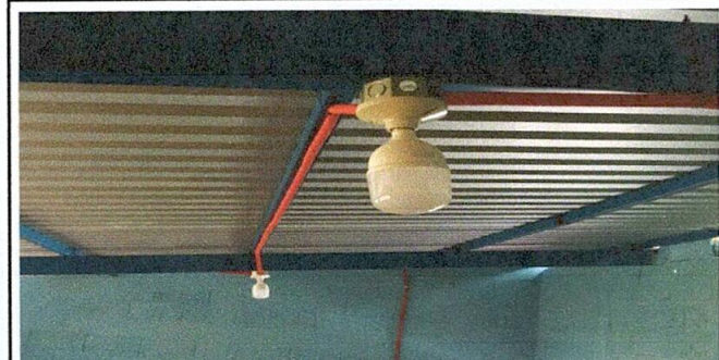
Foto 6: LA NUEVA INSTALACIÓN DE LA RED ELÉCTRICA DE LA ESCUELA YA TERMINADA.
