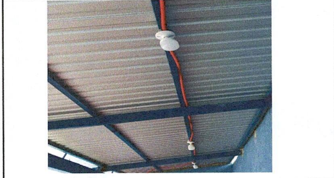
Foto 4: LA NUEVA INSTALACIÓN DE LA RED ELÉCTRICA DE LA ESCUELA YA TERMINADA.
