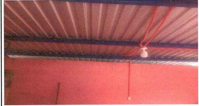
Foto 2: EL NUEVO TECHO DE LA COCINA DE LA ESCUELA YA INSTALADO.
