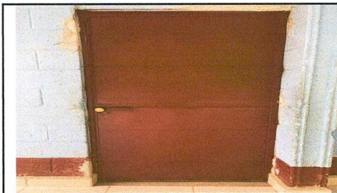
Foto 5: sustitucion de chapas
