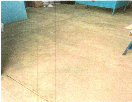
FOTO 3: SUSTITUCIÓN DE PISO DE CEMENTO LIQUIDO A PISO CERAMICO
