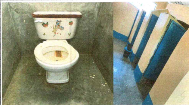
FOTO 5: SUSTITUCIÓN DE INODOROS, PUERTAS Y CHAPAS
