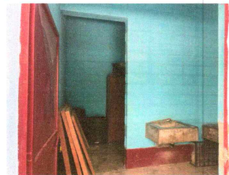
FOTO 6: SUSTITUCIÓN DE PUERTAS
