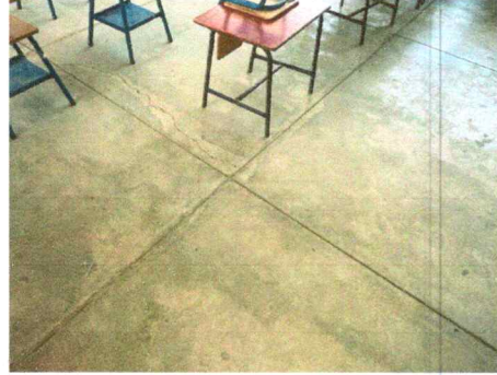
FOTO 2: SUSTITUCIÓN DE PISO DE CEMENTO LIQUIDO A PISO CERAMICO
