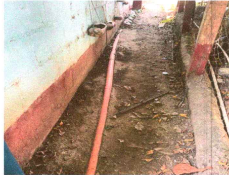
FOTO 4: SUSTITUCIÓN DE TUVO PVC DE RED PRINCIPAL DE AGUAS NEGRAS
