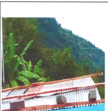
Foto 7: Sustrucción de láminas y estructura de soporte
