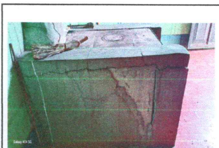
Foto 12: Reparación de estufa rural
