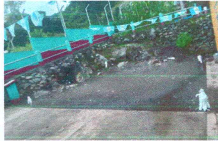
Foto 2: Sustitución de piso de torta de concreto
