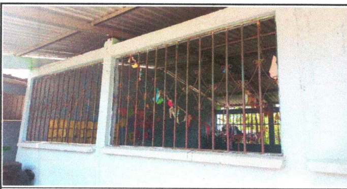
foto 23: Mejoramiento de pared con ventana
