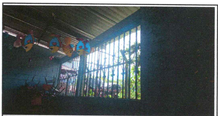
foto 24: Mejoramiento de pared con ventana
