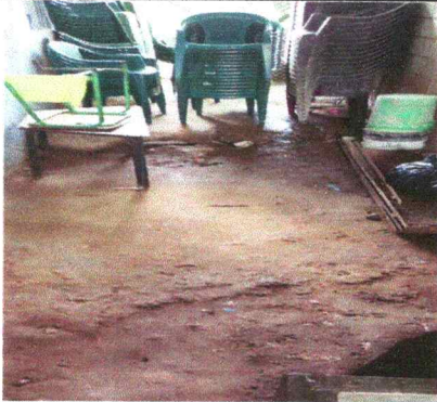
Foto 19: Reparación de piso de torta de concreto
