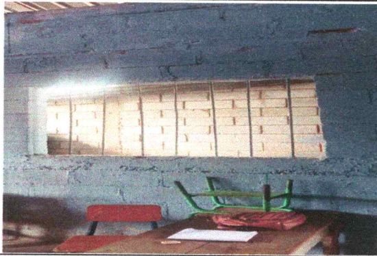
Foto 15: Sustitución de estructura de metal de ventana
