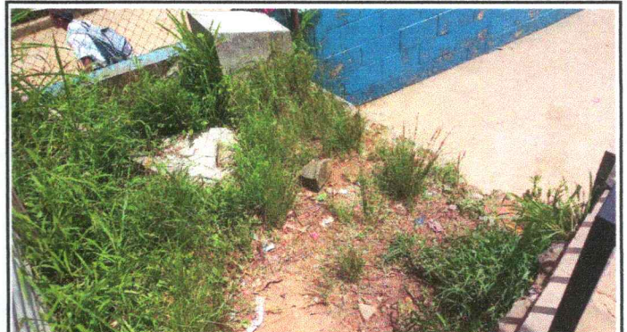
Foto 4: reparación de muro de contención.
