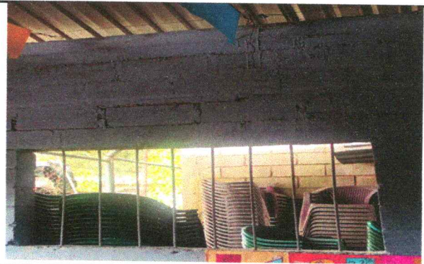
Foto 16: Sustitución de estructura de metal de ventana
