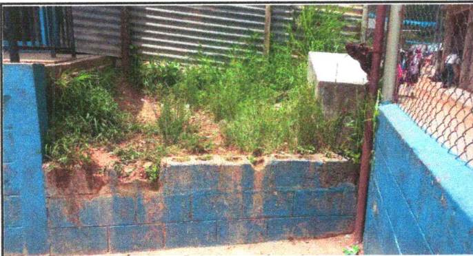
Foto 3: reparación de muro de contención
