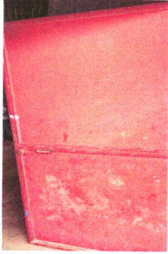
Foto 13: mantenimiento a puerta de metal
