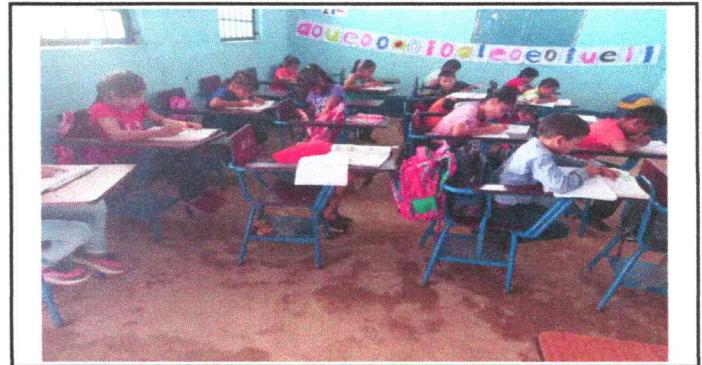
Foto 6: área donde se sustituirá piso cerámico
