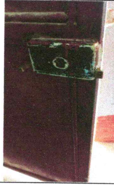
Foto 14: mantenimiento a puerta de metal.
