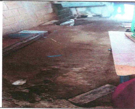
Foto 20: Reparación de piso de torta de concreto
