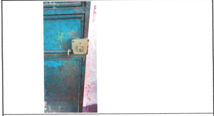
Foto 8: cambio de chapas en las puertas
