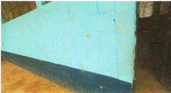
Foto 5: Pintura en paredes de aula en mal estado
