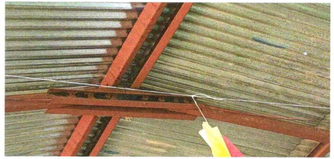
Foto 2: Sustitución de estructura de soporte de techo en mal estado
