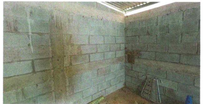
Foto 4: Repello en muros de cocina en mal estado
