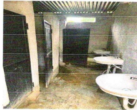
Foto 4: Sustitución de torta de cemento por piso de granito en baño
