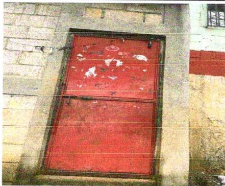
Foto 3: Mejoramiento y mantenimiento de puertas de aulas (chapa, lámina, bisagra, lijado y pintura).
