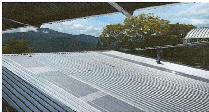
Instalación de láminas y costaneras Módulos 2 y 4
