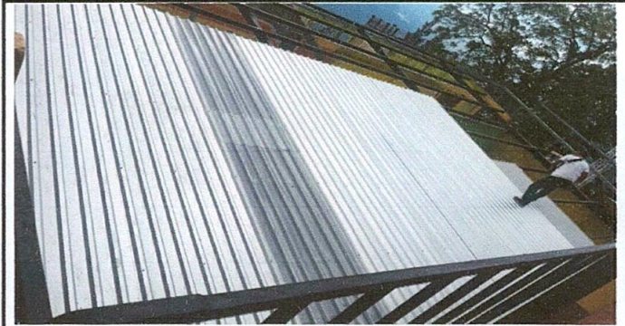
Colocación de lámina Módulo 2
