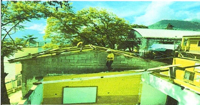
Eliminación de lámina y costaneras Módulo 1
