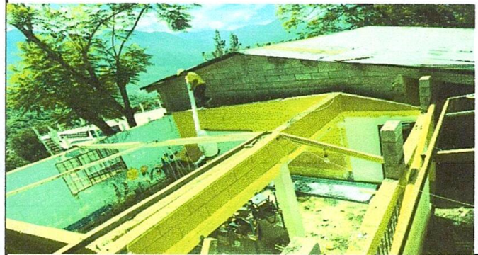
Cambio de Madera por estructura ade metal
