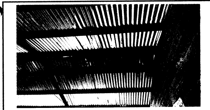
lamina con agujeros en módulo tres, y costaneras oxidadas
