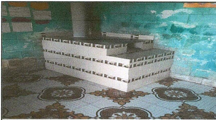
Foto 3: Reparación de plancha, forrada de azulejo y cambio de chimenea.
