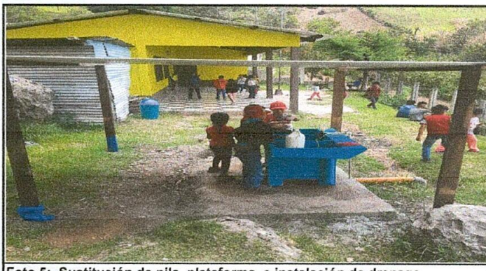
Foto 5: Sustitución de pila, plataforma e instalación de drenaje.
