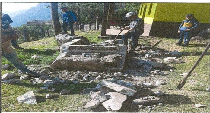
Foto 5: Demolición de tanque viejo
