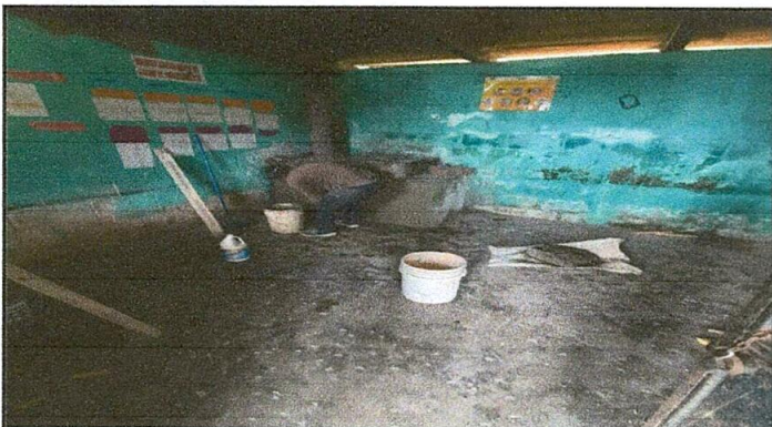
Foto 3: Reparación de plancha
