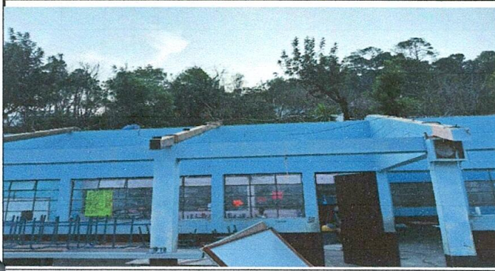
durante la instalación de módulo dos y tres
