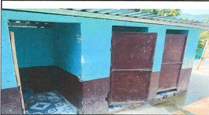
Lámina de baños durante la restauración
