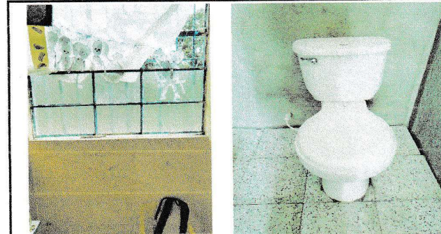
Foto 4: Sustitución de vidrios y sustitución de inodoros.
