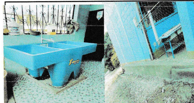
Foto 6: Sustitución de pila y reparación de banqueta.
