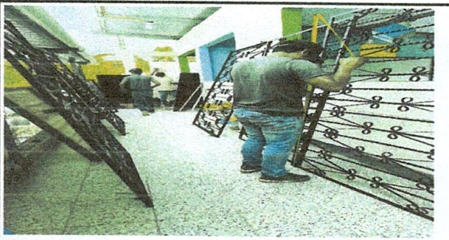
Foto 5: Sustitución de balcones metal.
