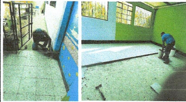
Foto1: Sustitución de torta de cemento por piso granito.
