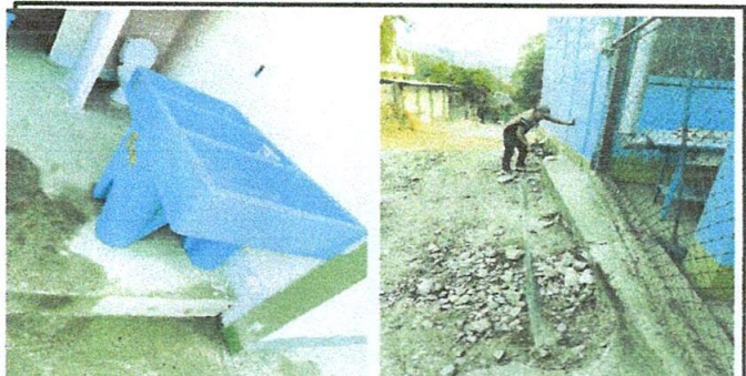
Foto 6: Sustitución de pila y reparación de banqueta.
