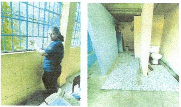
Foto 4: Sustitución de vidrios y sustitución de inodoros.
