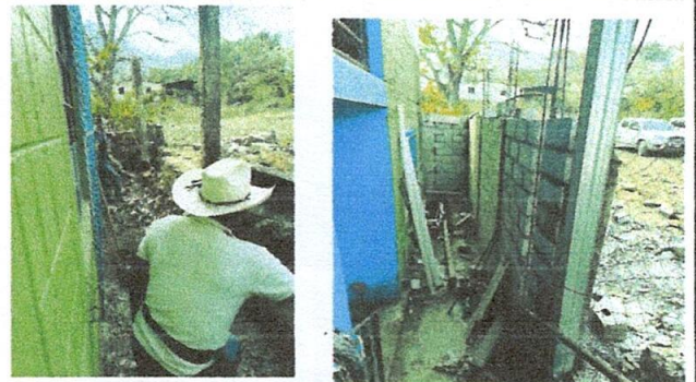
Foto 2: Reparación de muro perimetral .
