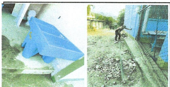
Foto 6: Sustitución de pila y reparación de banqueta.
