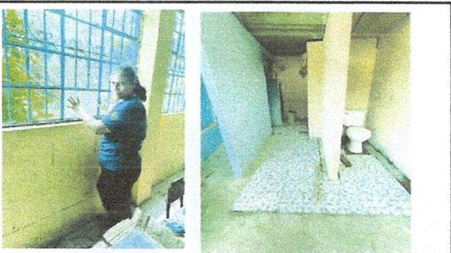
Foto 4: Sustitución de vidrios y sustitución de inodoros.
