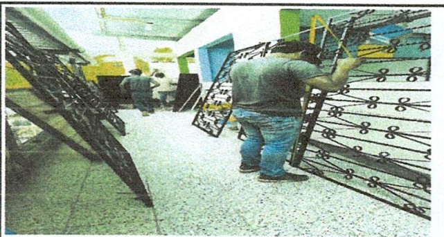
Foto 5: Sustitución de balcones metal.
