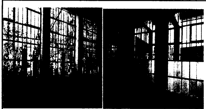
FOTO 4 SUSTITUCIÓN DE VIDRIOS EN VENTANAS
