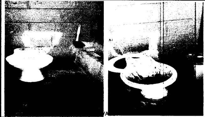
FOTO 2 NECESIDAD DE SUSTITUIR INODOROS
