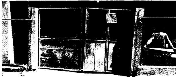
FOTO 3 SUSTITUCIÓN DE PORTÓN ENTRADA PRINCIPAL
