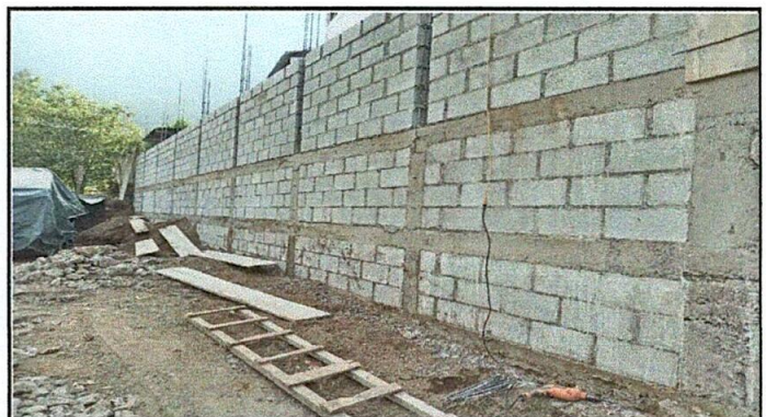
Foto 4: muro perimetral ya con un 98% de avance
