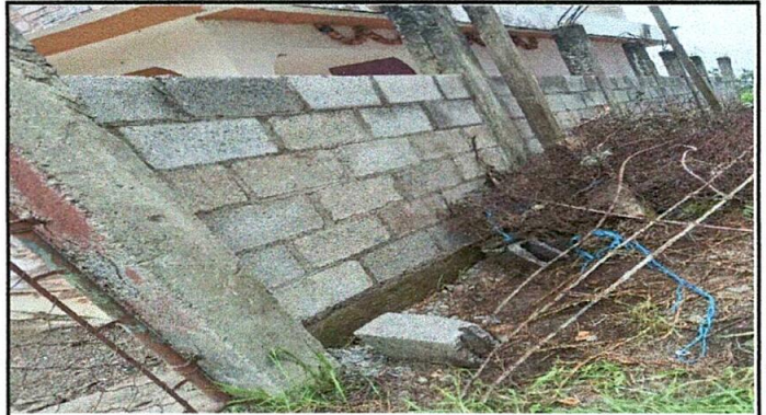
Foto 2: muro perimetral ya con un 90% de avance
