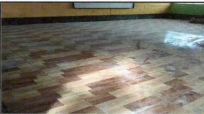
Foto 3: Aula 3 piso finalizado.
