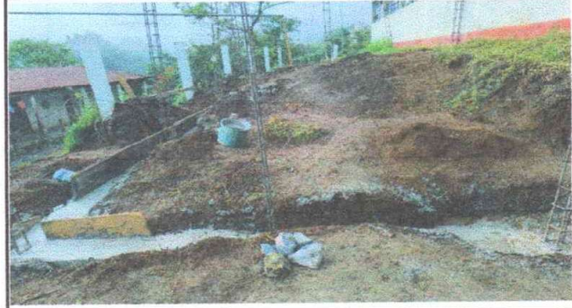
Foto 2: Entrada de puerta
