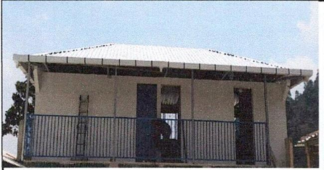
Foto1: Sustitución de lámina por lamina troquelada, sustitución de baranda de metal.
