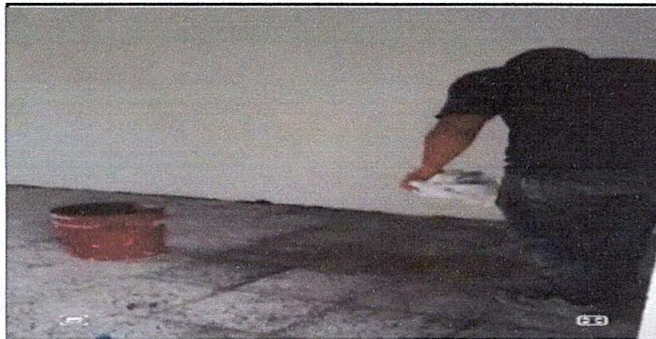
Foto 5: Sustitución de piso de concreto por cerámico
