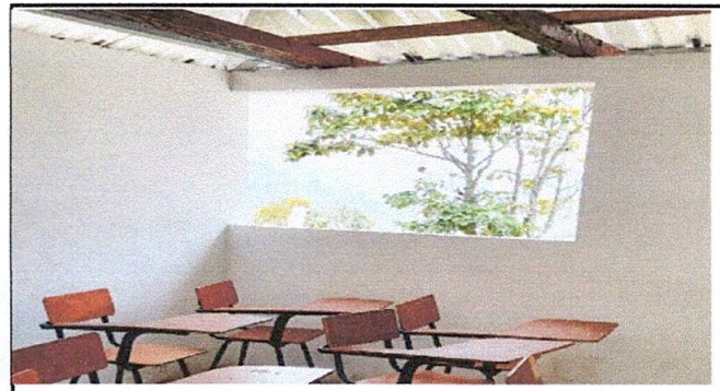
Foto 4: Sustitución de ventanas de madera por metal más vidrio
