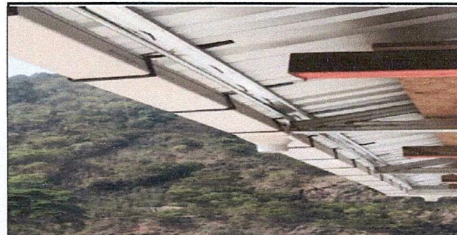
Foto 6: Sustitución de canales de tubo por canales de PVC
