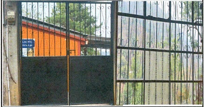
Foto 6: Remodelación de portón e instalación de vidrios.
