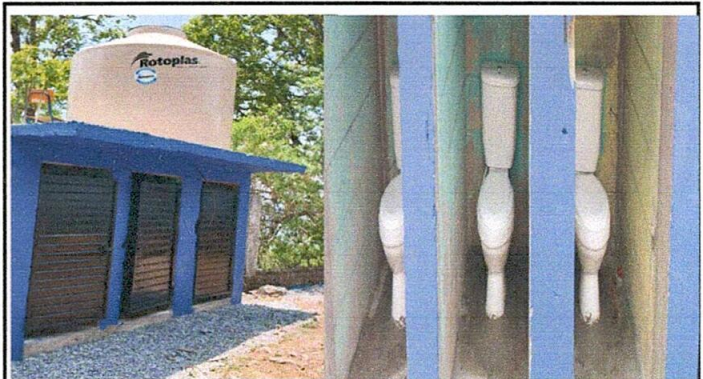
Foto 4: Reforzamiento en soleras, paredes, piso, losa, sustitución de sanitarios, puertas y depósito de agua rotoplas en los baños.
