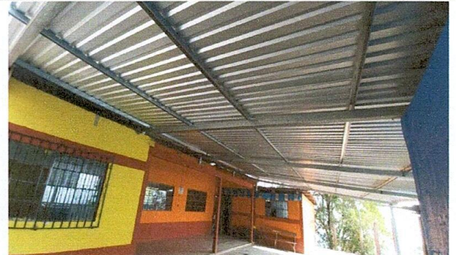
Foto 2: Sustitución de estructura aulas y patio.
