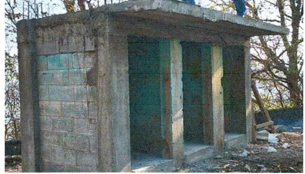
Foto 2: Reforzamiento de soleras, pared y piso de torta de concreto en los baños
