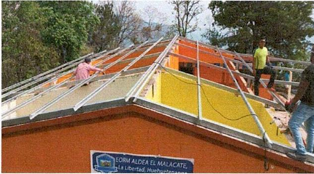
Foto 1: Instalación de estructura completa de tubo cuadrado, costaneras y lámina.
