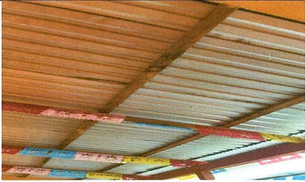
Foto 1: Sustitución de lámina calibre 26 y estructura de aulas.
