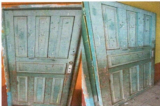
Foto 5: Sustitución de puertas.
