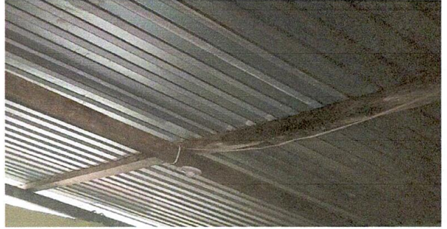
Foto 2: Sustitución de cableado eléctrico
