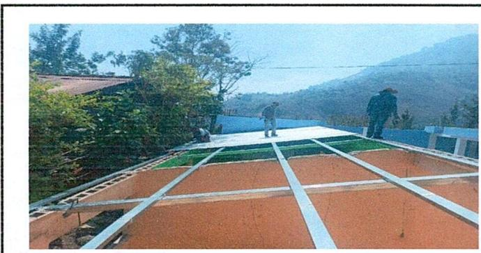
Foto 3: Instalación de láminas sobre costaneras
