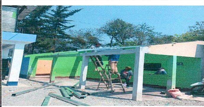
Foto1: Intalacion de estructura de soporte de metal
