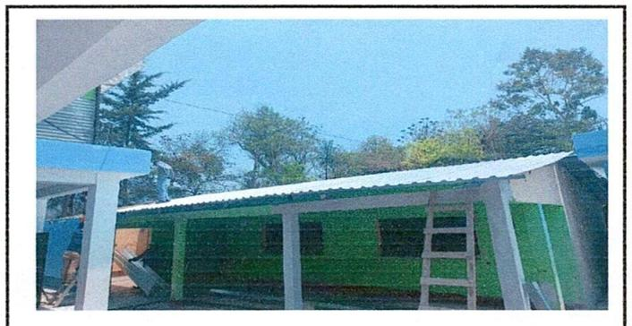
Foto 4: Instalación del techo de láminas troqueladas
