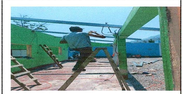
Foto 2: Instalación de costanera de soporte de metal
