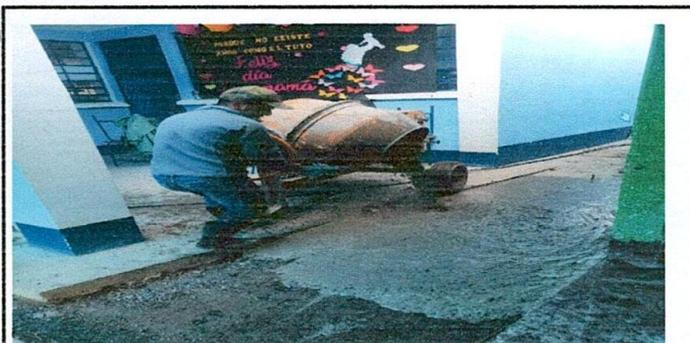
Foto 5: Fundición de torta de concreto
