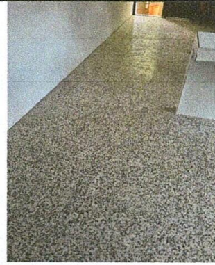
Foto 10: Sustrucción de piso cerámico
