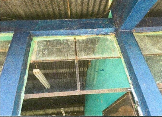
Foto 7: Sustrucción de vidrios fijos de puertas
