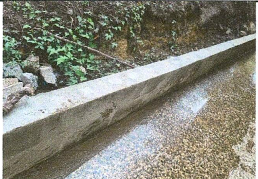
Foto 12: Muro de contención
