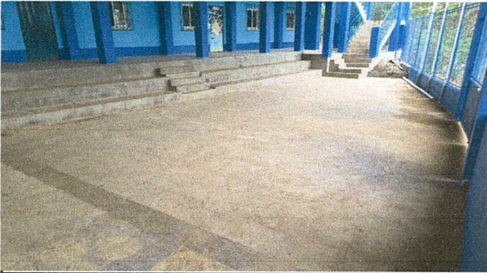
Foto 9: Reparación de gradas
