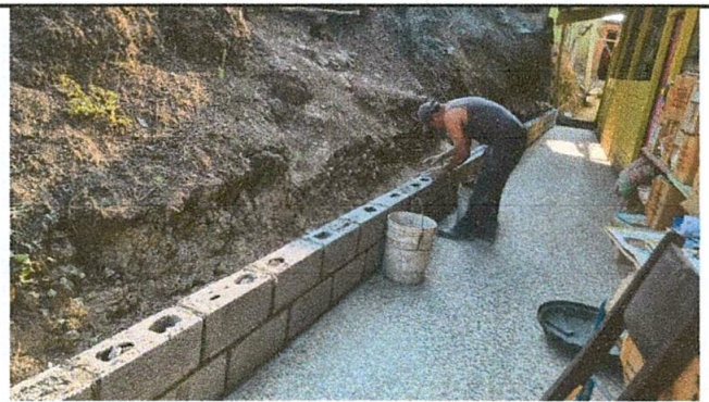
Foto 12: Muro de contención
