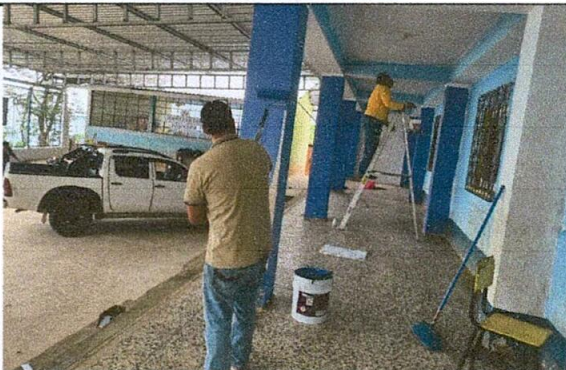
Foto11: Remodelación de Pintura
