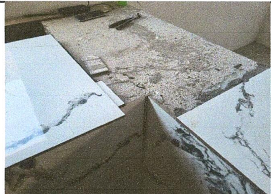
Foto 10: Sustitución de piso cerámico
