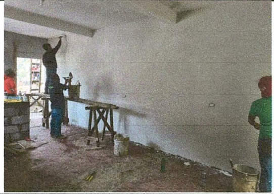
Foto 8: Repello en muro
