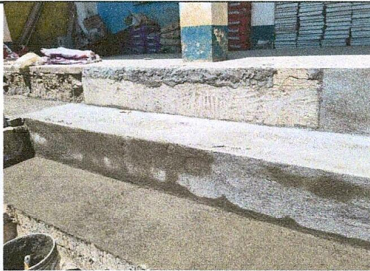
Foto 9: Reparación de gradas
