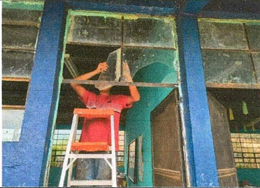
Foto 7: Sustitución de vidrios fijos de puertas
