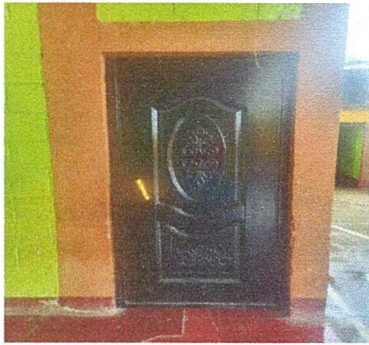
Foto 3: Puertas nuevas instaladas
