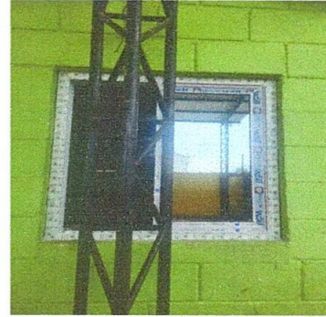
Foto 4: Ventanas nuevas instaladas
