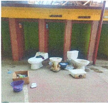
Foto 3: Instalación de inodoros
