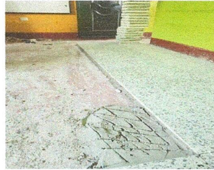
Foto 2: pegado de piso en una de las aulas
