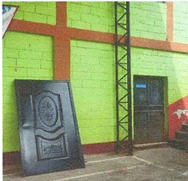
Foto 5: Instalación de puertas planta baja
