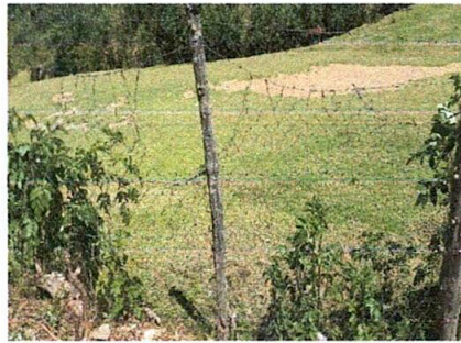
Foto 3: Reparación de muro perimetral
