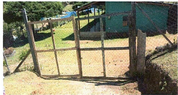
Foto 4: Sustitución de porton principal de la escuela
