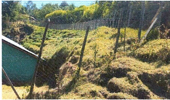
Foto 1: Reparación de muro perimetral
