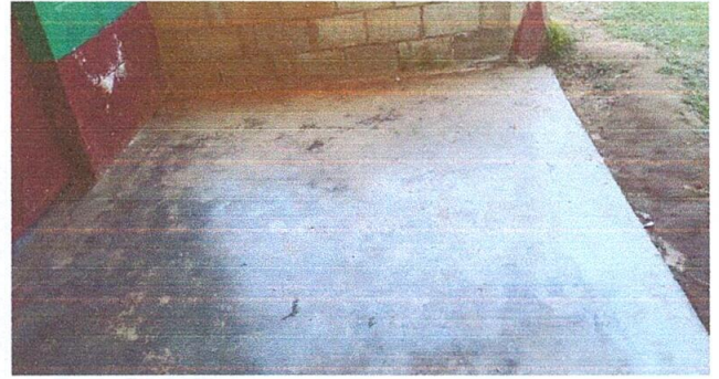
Foto 2: Sustitución de piso de torta de concreto
