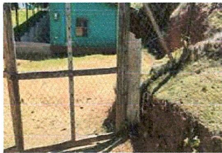
Foto 5: Sustitución de porton principal de la escuela
