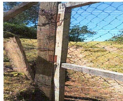
Foto 6: Sustitución de porton principal de la escuela
