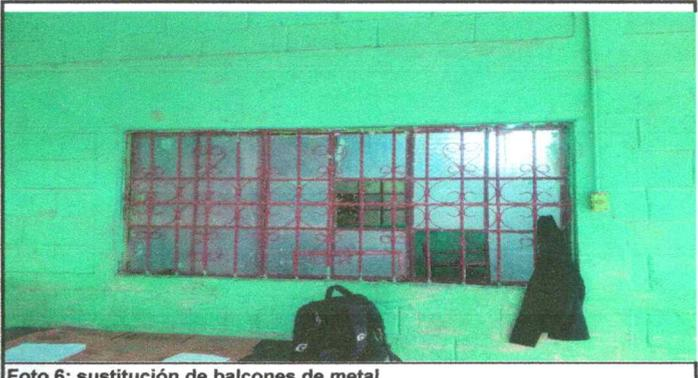
Foto 6: sustitución de balcones de metal
