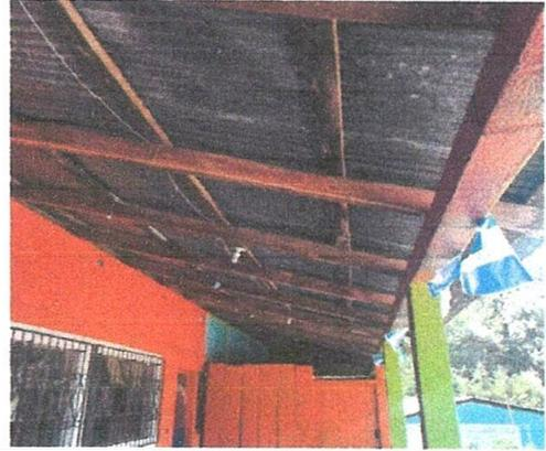
Foto 2: Se realizará sustitución de estructura de madera, por metal y reparación de sistema eléctrico, para evitar algún incendio en las instalaciones del centro educativo.
