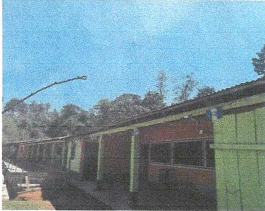
Foto 1: Se realizará sustitución de lámina por lámina troquelada aluzinc calibre 26, debido a que en invierno caen muchas goteras sobre los escritorios y muebles del aula.
