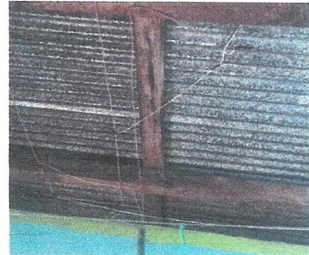
Foto 4: Sustitución de cableado eléctrico, porque se cuenta con el riesgo de que un corto circuito provoque un incendio.
