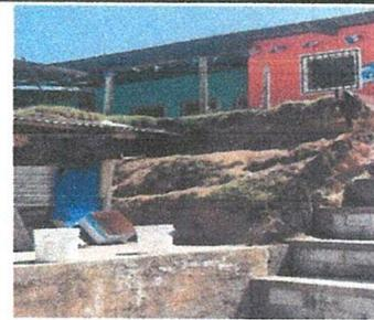
Foto 6: Se realizará reparación del muro de contención, debido a que por los años de haberse construido se ha ido deteriorando, poniendo en peligro a los estudiantes del centro educativo.
