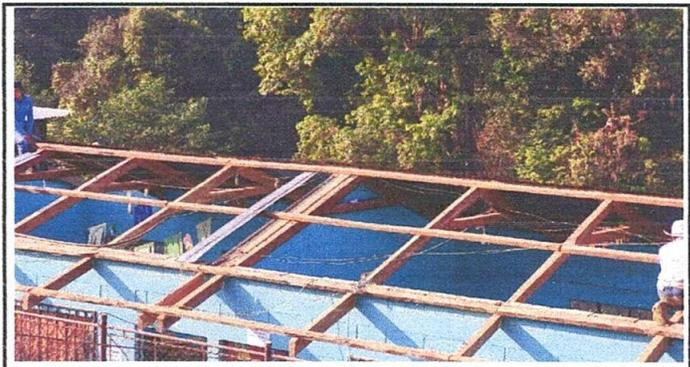
Foto 4: SUSTITUCION DE ESTRUCTURA DE SOPORTE
