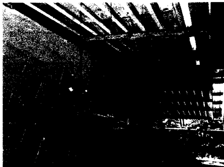
Foto 11: Costaneras del techo de la cocina deterioradas ( surtitiuir por nuevas )
