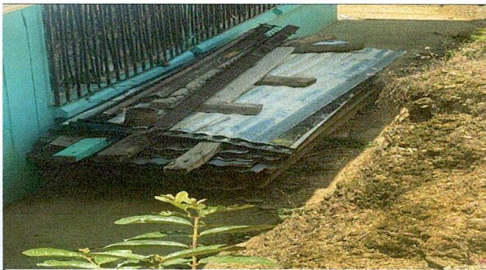
Foto 3: LÁMINAS QUITADAS DEL MODULO 3 Y BAÑOS
