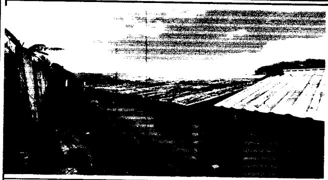
Foto 1: TECHO A CAMBIAR, DOS AULAS
