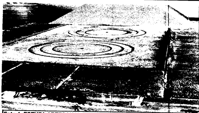
Foto 4: ESTUFA ARTESANAL EN MAL ESTADO
