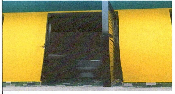
Foto 2: Concluido Sanitarios, lavamanos piso y repello.
