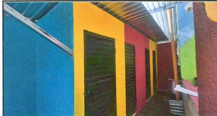
Foto 4: Culminación de colocación de puertas de metal.
