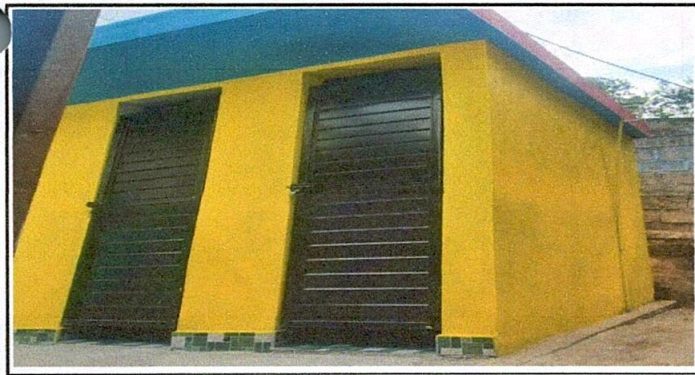
Foto 5: Aplicación de repello en los baños.
