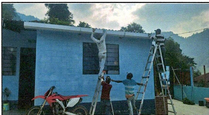
Foto 3: Colocación de canal para caída de agua pluvial.
