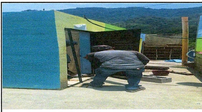
Foto 4: Colocación de puerta de metal.
