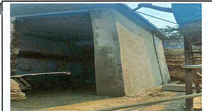
Foto 5: Aplicación de repello en los baños.
