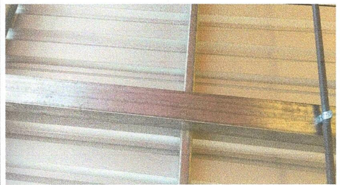
Foto 2: cambio de estructura metálica
