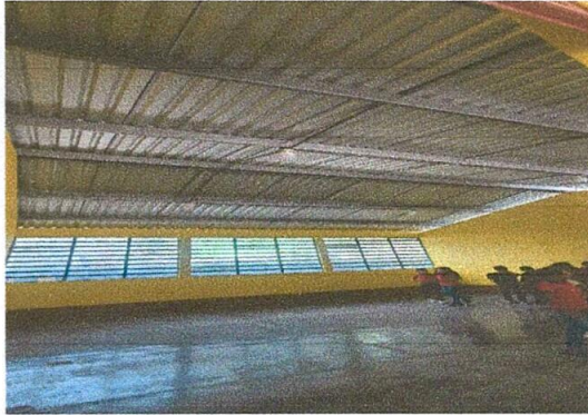
Foto1: Cambio de techo
