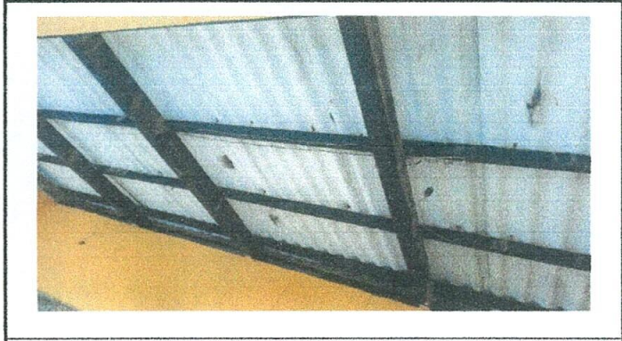
Foto 2: cambio de estructura metálica
