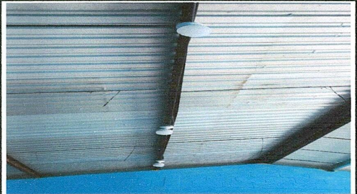
Foto 2: REPARACIÓN DE CABLEADO ELECTRICO Y MANO DE OBRA CABLEADO
