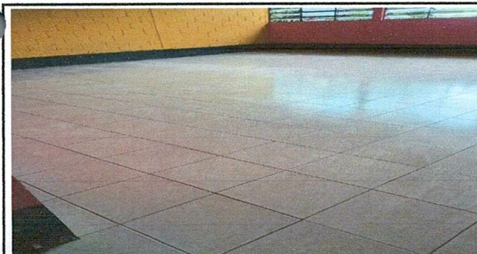
Foto 5: SUSTITUCIÓN DE PISO POR CERÁMICO
