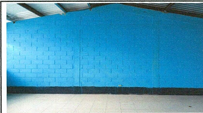
Foto 3: APLICACIÓN DE PINTURA INTERIOR Y EXTERIOR
