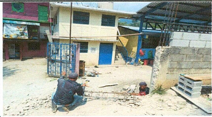
Foto1: SUSTITUCIÓN DE PORTON DE METAL
