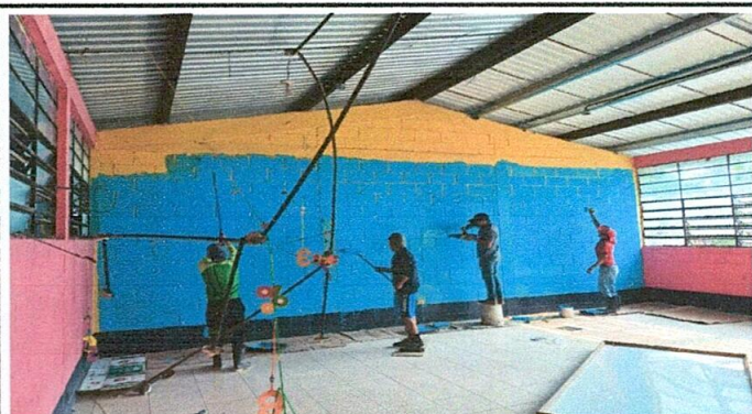
Foto 3: APLICACIÓN DE PINTURA INTERIOR Y EXTERIOR
