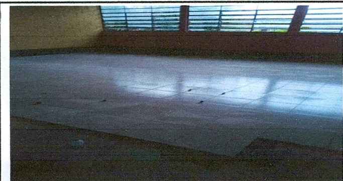
Foto 5: SUSTITUCIÓN DE PISO POR CERÁMICO
