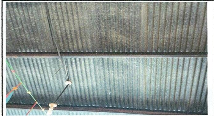
Foto 4: SUSTITUCIÓN DE LAMINAS POR LAMINAS TROQUELADAS CALIBRE 26
