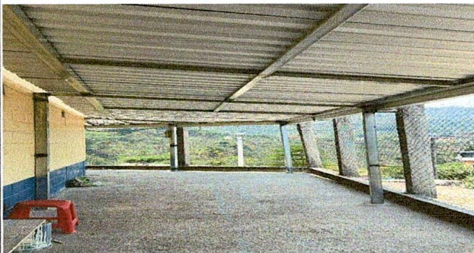
Foto 3: colocación de lamina aluzinc
