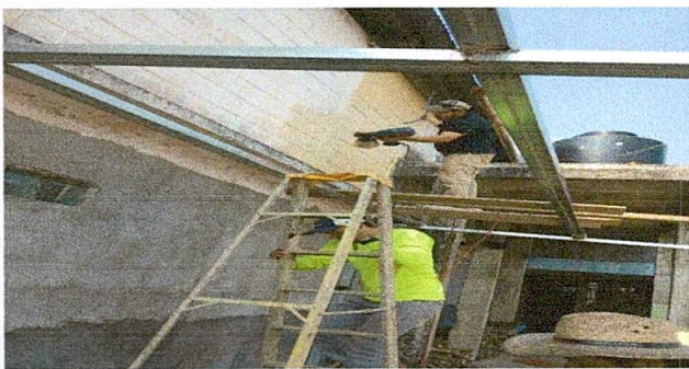
Foto 5: Instalación de lamina
