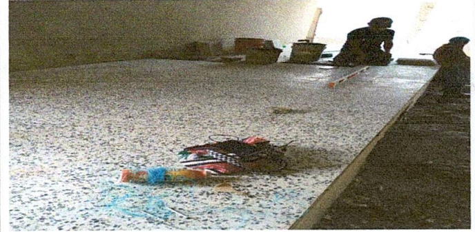
Foto 6: Colocación de piso de granito
