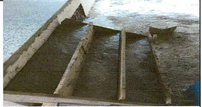
Foto 2: Reparación de gradas y colocación de piso
