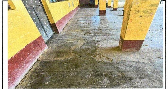
Foto 4: Piso agrietado y en mal estado.
