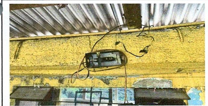
Foto 5: Instalacion electrica en mal estado.
