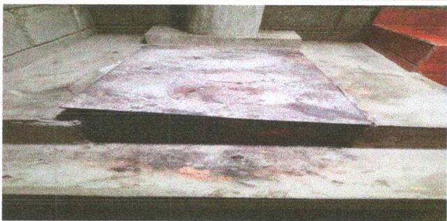
Foto 5: Sustitución de plancha.
